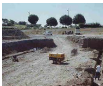
Rampa de acceso
