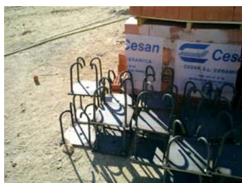
Acopio materiales (I)
