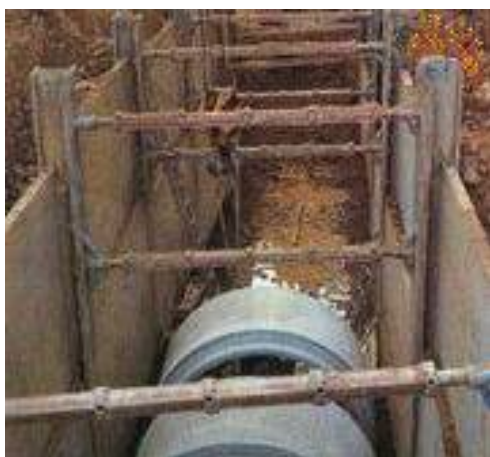
Entibación de zanja de saneamiento
