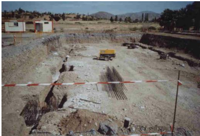
Vista general de la excavación
